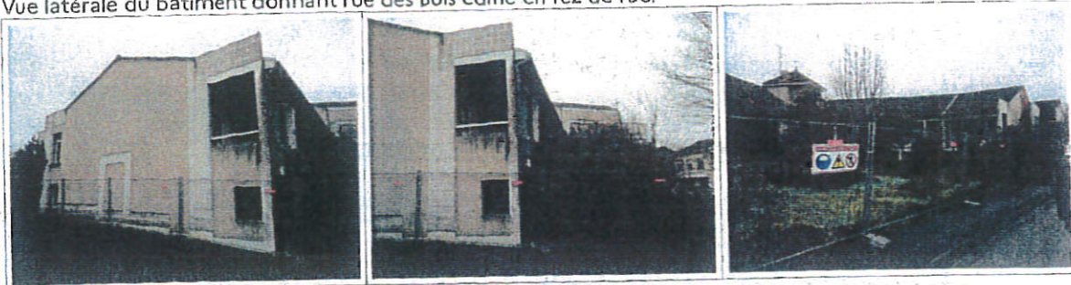
Terrain autour du bâti en nature d'espace vert mal entretenu.
