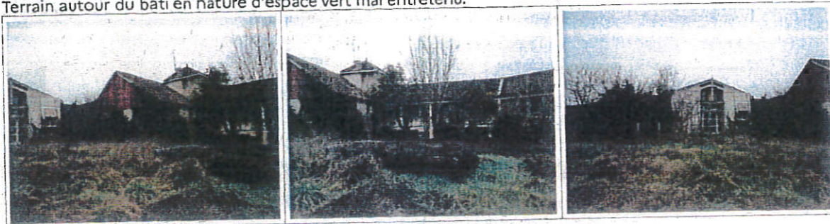
Pour le 2 e bâtiment contigu voué à la démolition et situé dans le prolongement du précédent : grande entité immobilière vétuste et à l'état d'abandon, à l'architecture désuète et anachronique, de forme rectangulaire, élevée d'un simple rez-de-chaussée, avec une cour intérieure disposée en son centre.
