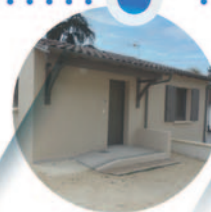
CREYSSE Résidence du Bourg
